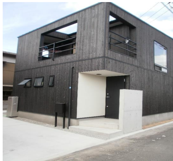
素焼施工例 (日本)
