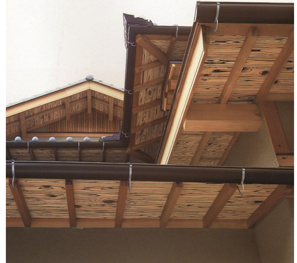
浮造施工例 (日本)
