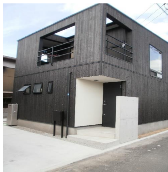
素焼施工例(日本)
