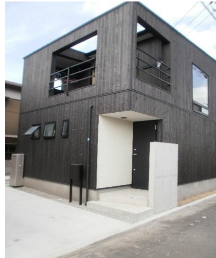
素焼施工例 (日本)
