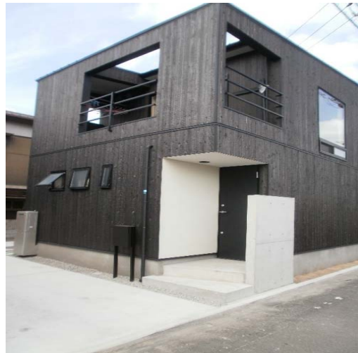
素焼施工例 (日本)
