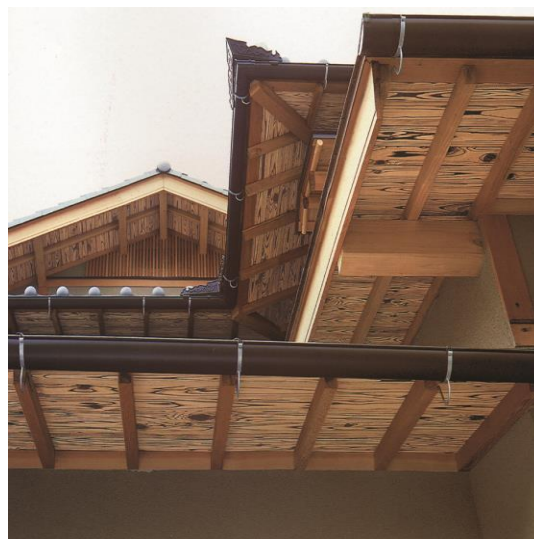
浮造施工例 (日本)
